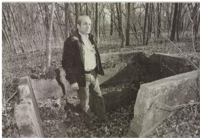
2. számú kép. Az egyetlen megmaradt betonmedence romjai (Új Néplap, Szolnok)
