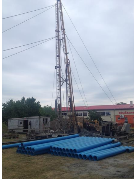
1.kép. A kútúróberendezés előtérben a PVC béléscsövekkel és szűrőcsövekkel
