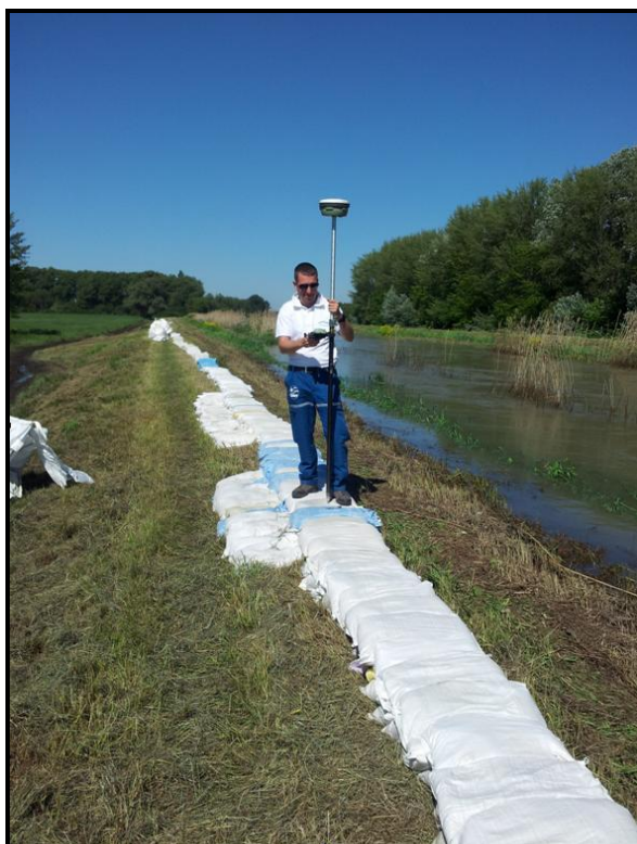
23. fotó: Magassági hiány felmérése GPS-sel
