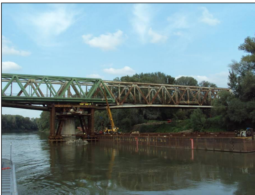
18. fotó: M4 autópálya építése a Tisza 346 fkm szelvényében
