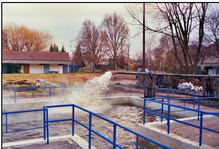
7. fotó: A 630,7 m mélységű strandi kút kompresszoros termelése
