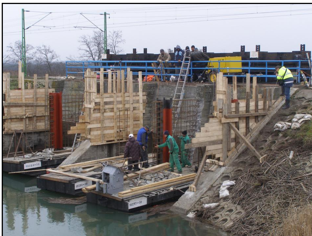
6. fotó: Nkfcs. 14. jelű műtárgy ideiglenes elzárás hornyainak magasítása
