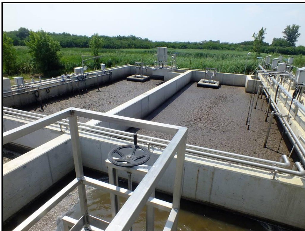
14. fotó: A fegyverneki szennyvíztisztító telep aerob medencéi
