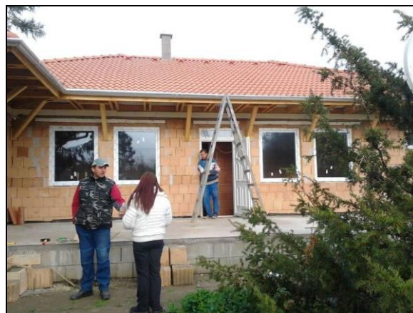
64. fotó: Kőtelek - őrházépítés
