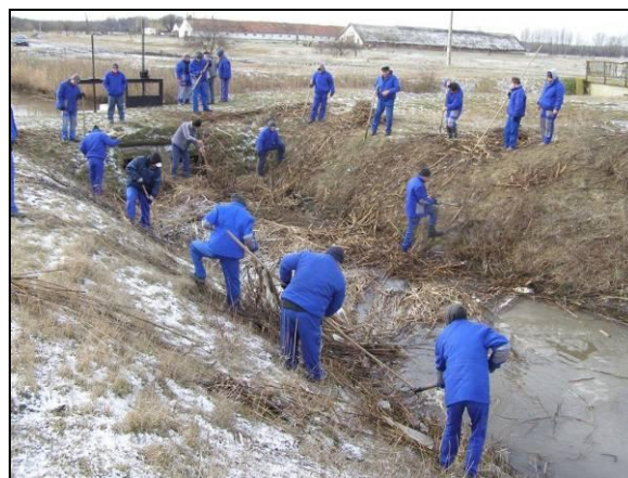
72. fotó: Karcag – vízfolyás akadály eltávolítása, nádirtás
