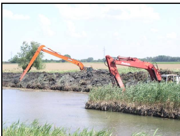
78. fotó, 79. fotó: Dolgoznak a kotrógépek a tározótér kialakításán
