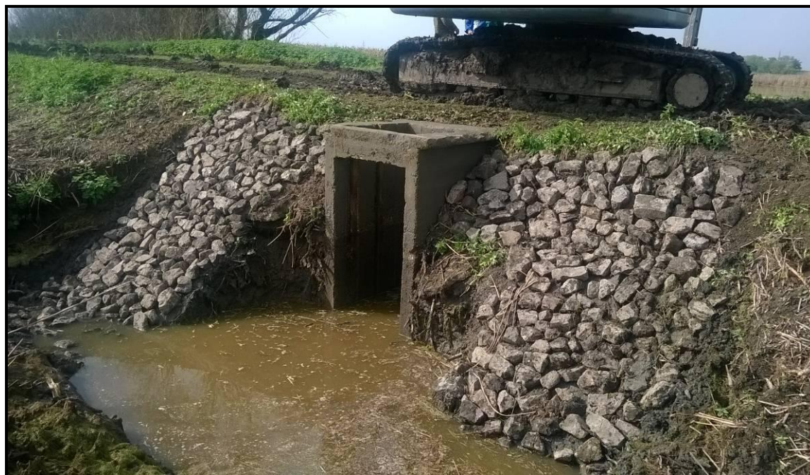
77. fotó: Felújított műtárgy a csatorna 6+090 km szelvényében
