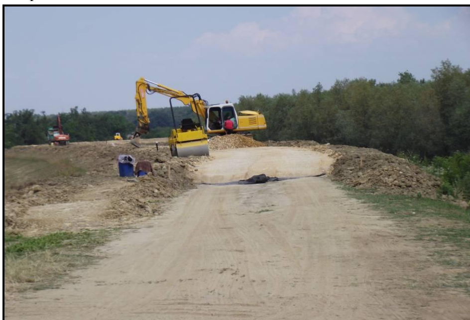
53. fotó: Több helyen a töltés magasítását is el kellett végezni
