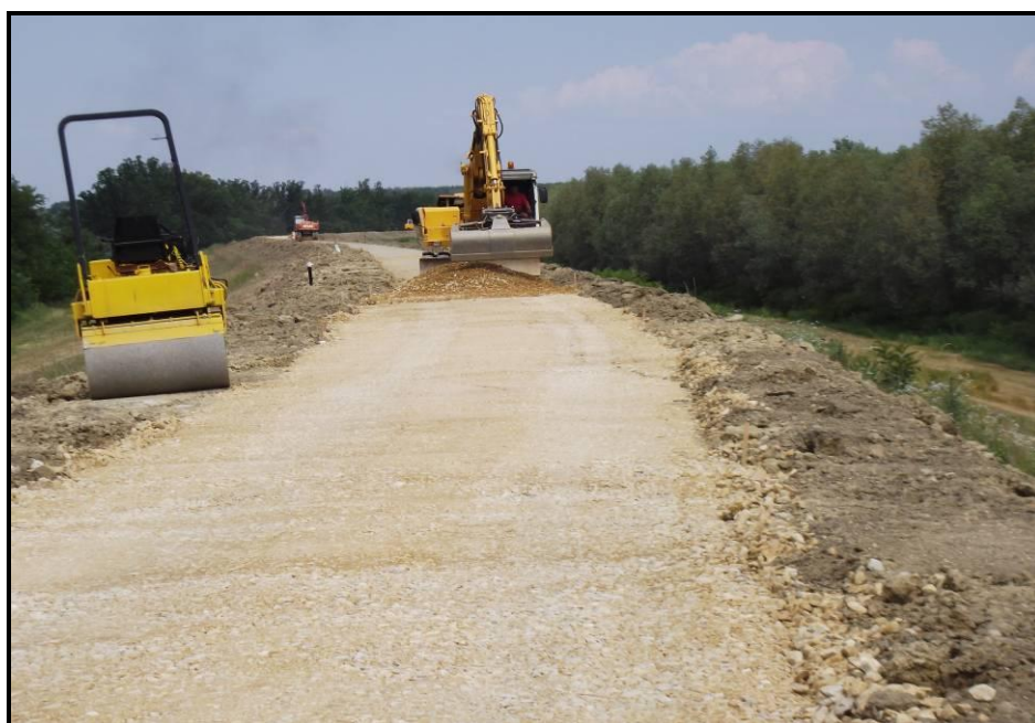
52. fotó: Kerékpárút építés közben
