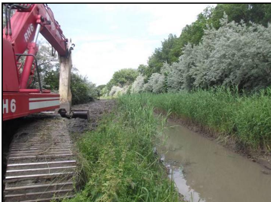
3. fotó: Nk. III-2-4-2. öntözőcsatorna kotrása
