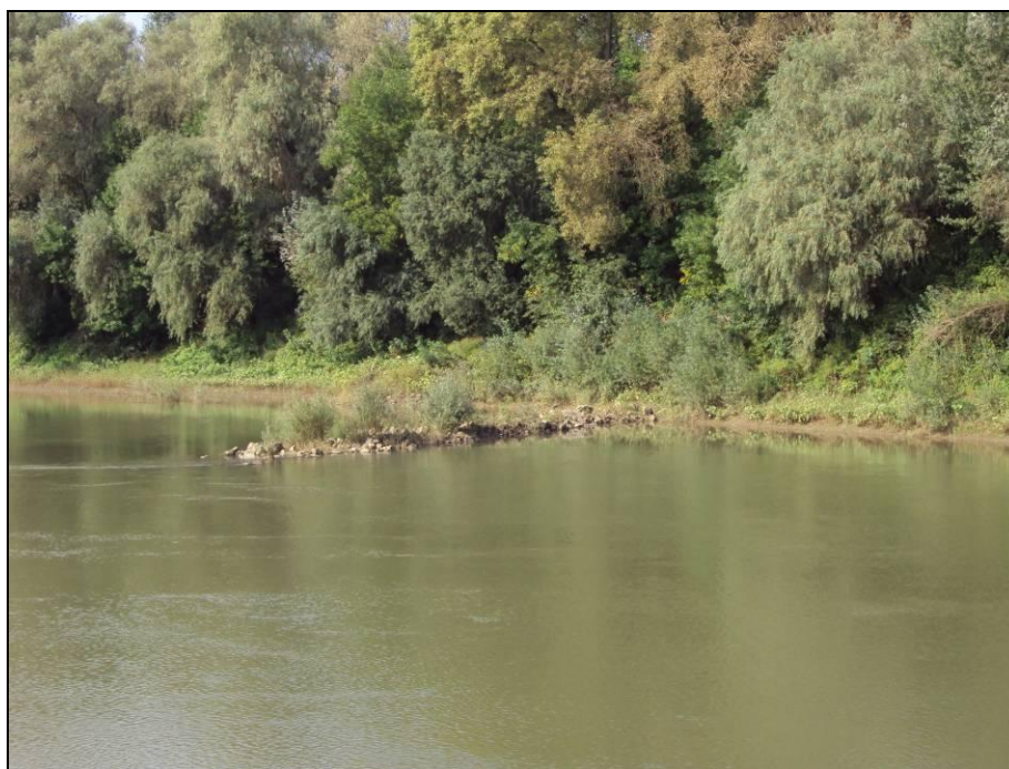
19. fotó: Folyószabályozási mű a Taskonyi híd alatt
