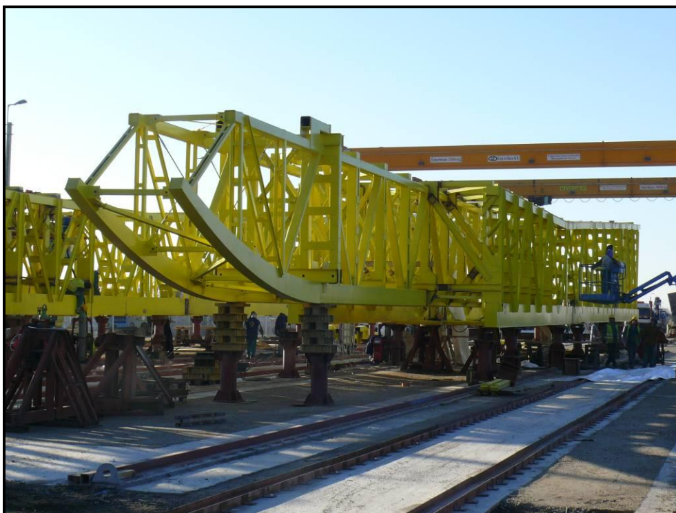
59. fotó: Tisza híd, jobb parti szerelőtér
