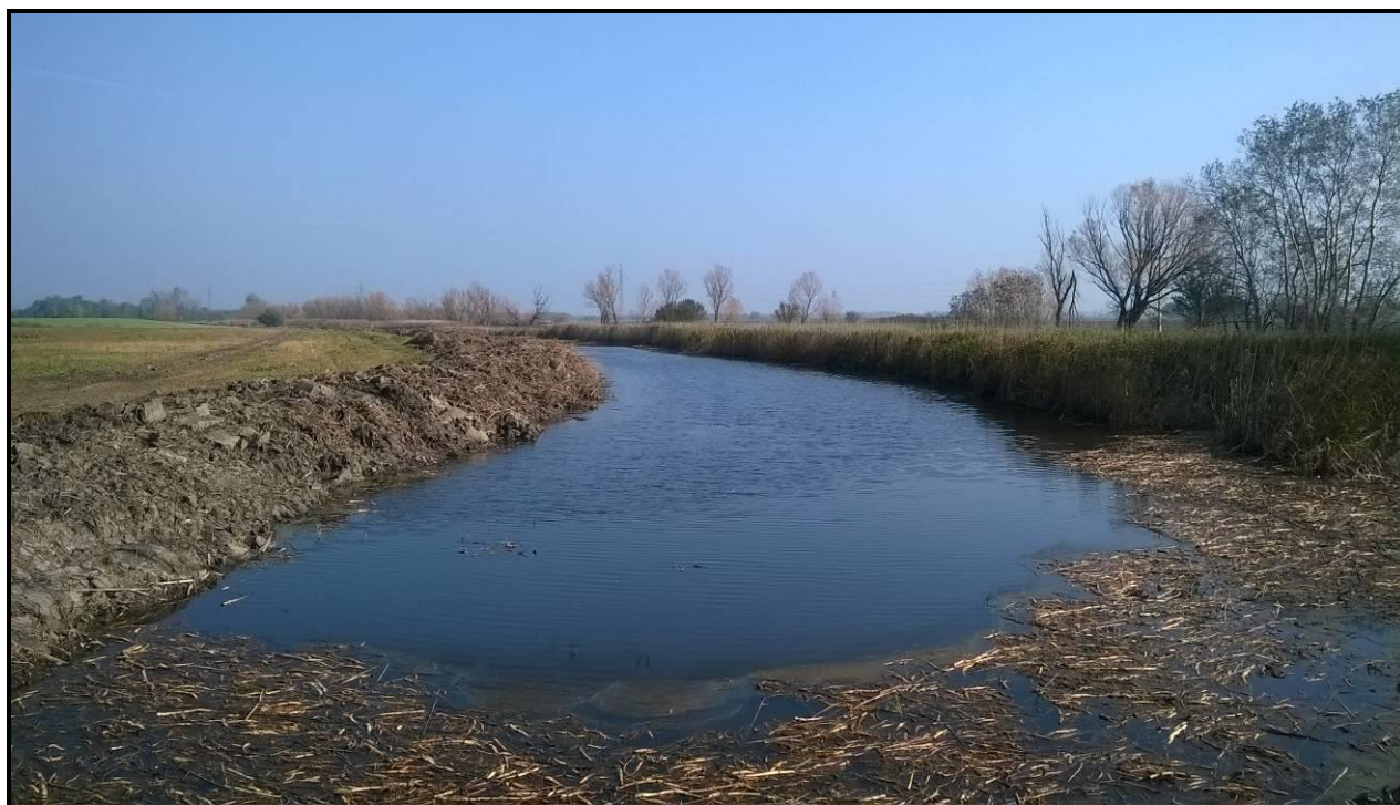
80. fotó: A kialakított tározótér és megfelelő magasságúra kiképzett depónia
