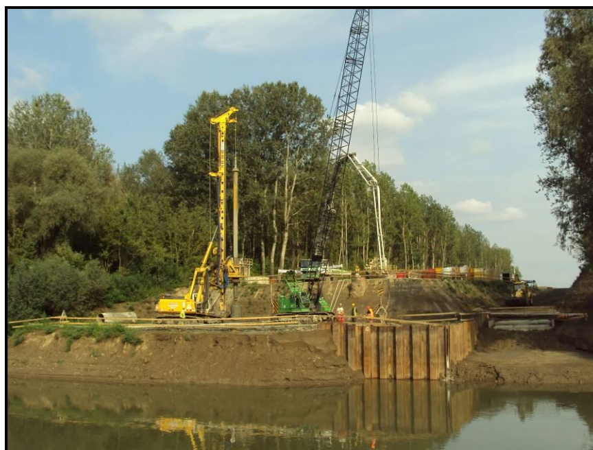
17. fotó: Szolnok-Szajol vasútvonal tiszai hídjának felújítási munkálatai
