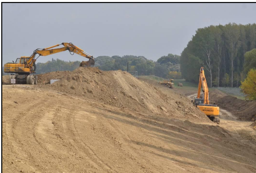
28. fotó: Töltésépítés Szelevény határában
