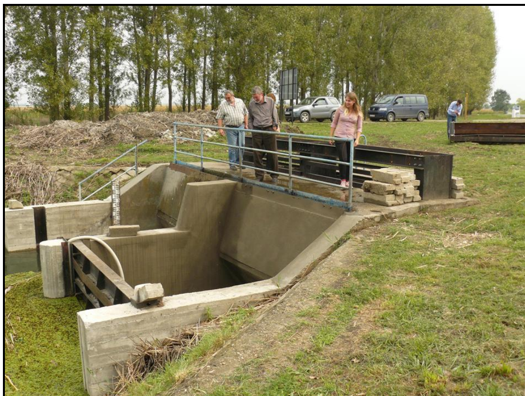
5. fotó: Nfcs. 34. jelű műtárgy rekonstrukciós munkái
