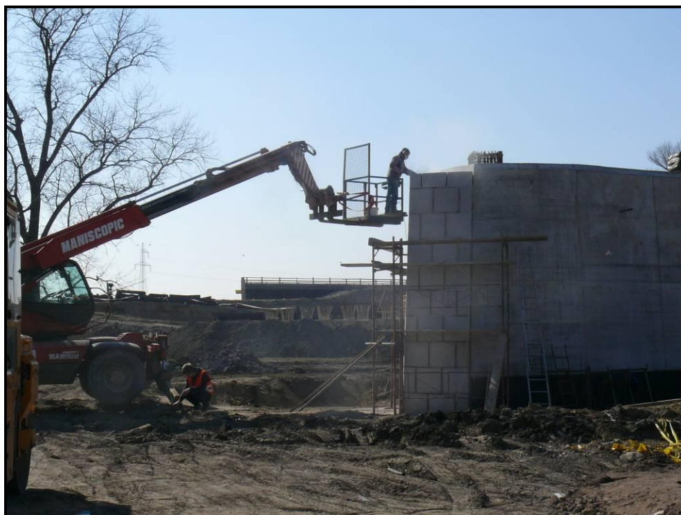
58. fotó: Zagyva híd, mederpillér
