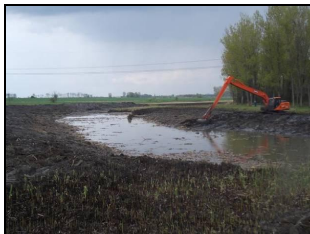
78. fotó, 79. fotó: Dolgoznak a kotrógépek a tározótér kialakításán
