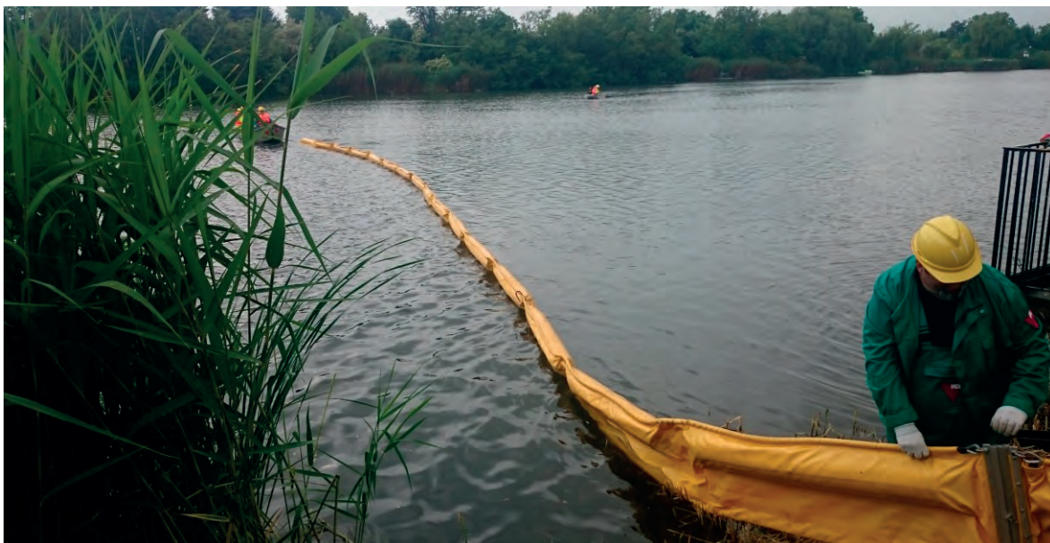
49. kép Merülőfal telepítése az Alcsi-Holt-Tiszába a MOL NyRt. Szajoli bázistelepénél
