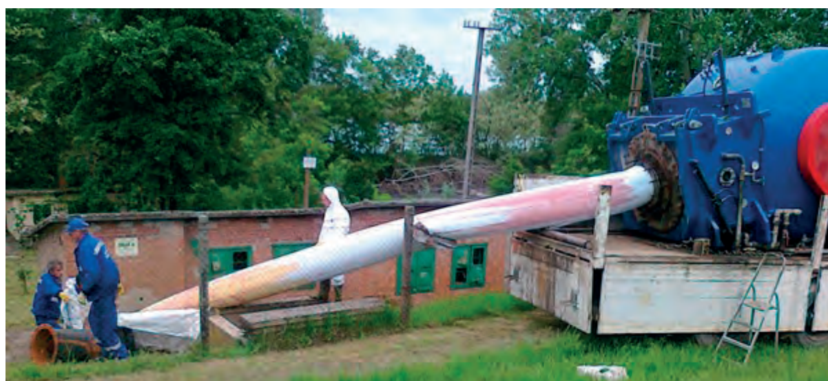
58. kép Cibak II. szivattyútelepi DN 500 acél nyomócsőbélés kivitelezése
