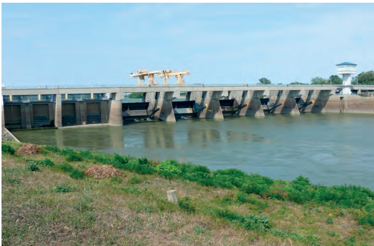
3. kép Alacsony vízállásnál a halaknak esélye sem volt a régi halcsatorna igénybevételére. Az irányító torony bal oldalánál látható, hogy a belépő nyílás magasabban van, mint a vízfelszín.
