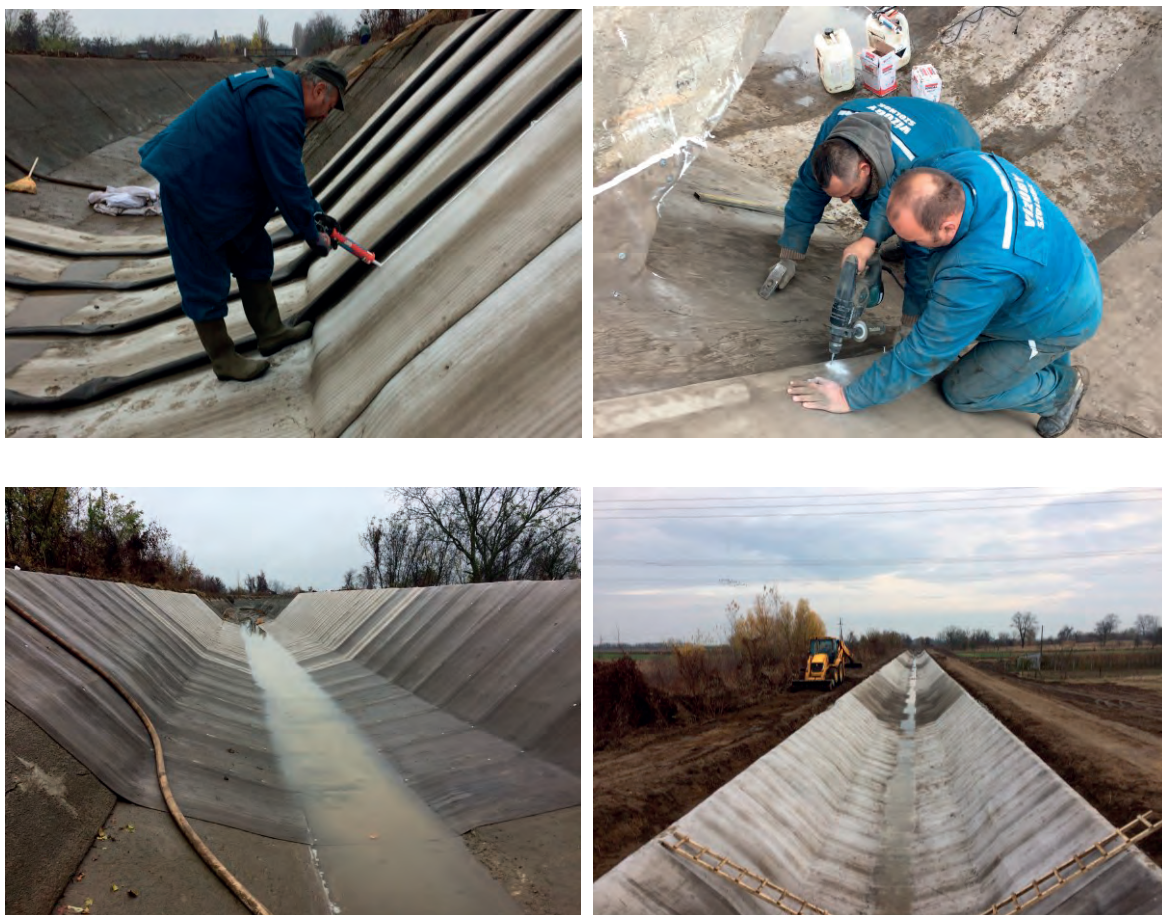
12. kép Betonpaplan készítése a Tiszafüredi-főcsatorna medrében
