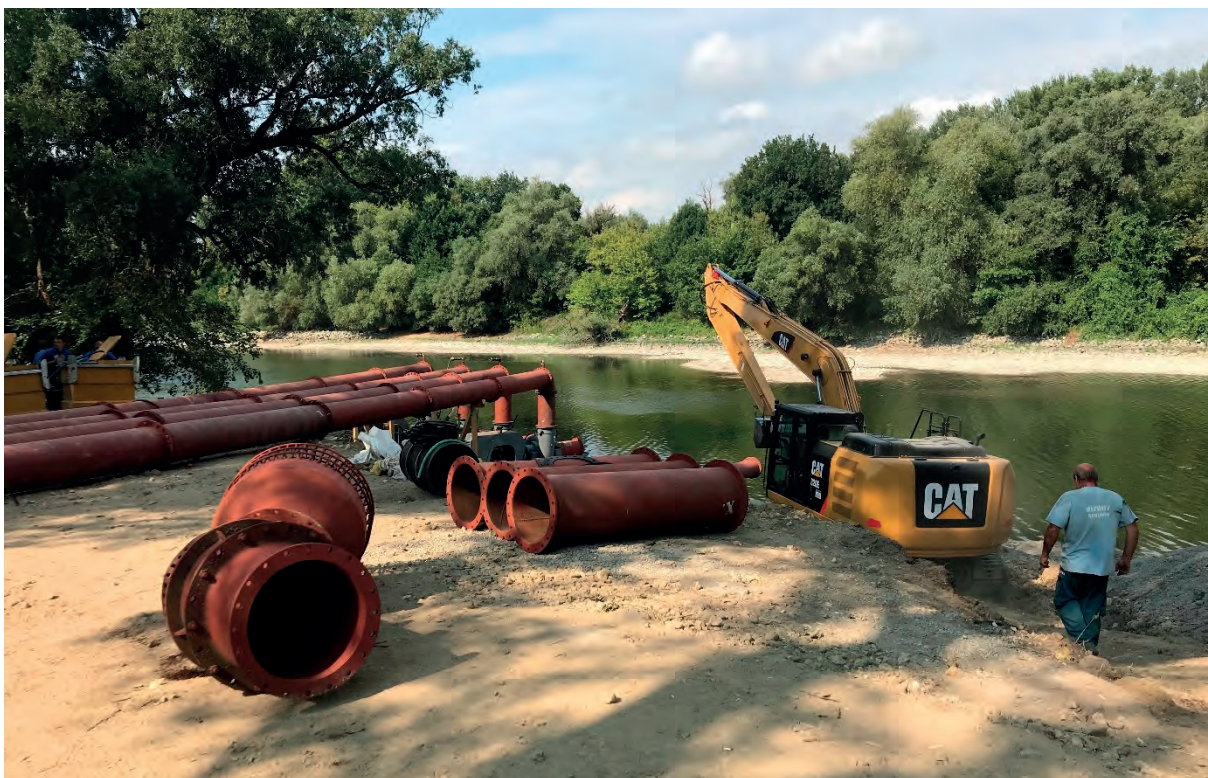
45. kép Négyes számú szivattyúegység szívórészének újra telepítése
