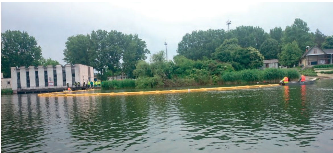
50. kép Merülőfal telepítése az Alcsi-Holt-Tiszában a MOL NyRt. Szajoli bázistelepénél
