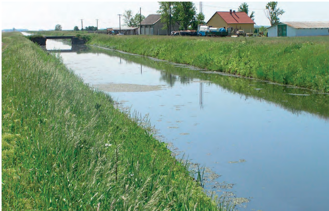
2. kép A Karcagi-I csatorna 5+825 km szelvényben
