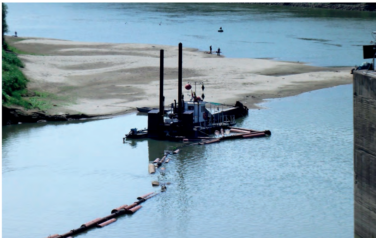
27. kép Kiskörei hajószilip alvízi várakozó terének hidromechanizációs kotrása
