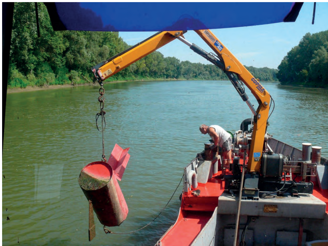
25. kép Úszóbója tisztítása és igazítása a Martfű kitűző hajóval
