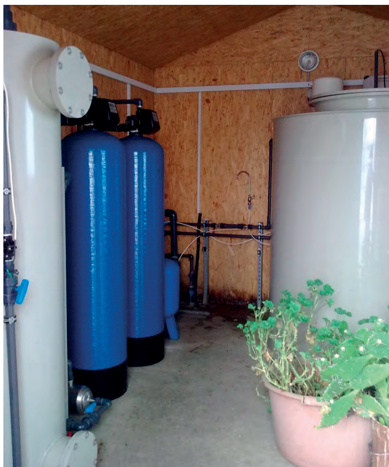
10. kép Egyedi vízkezelő rendszer
