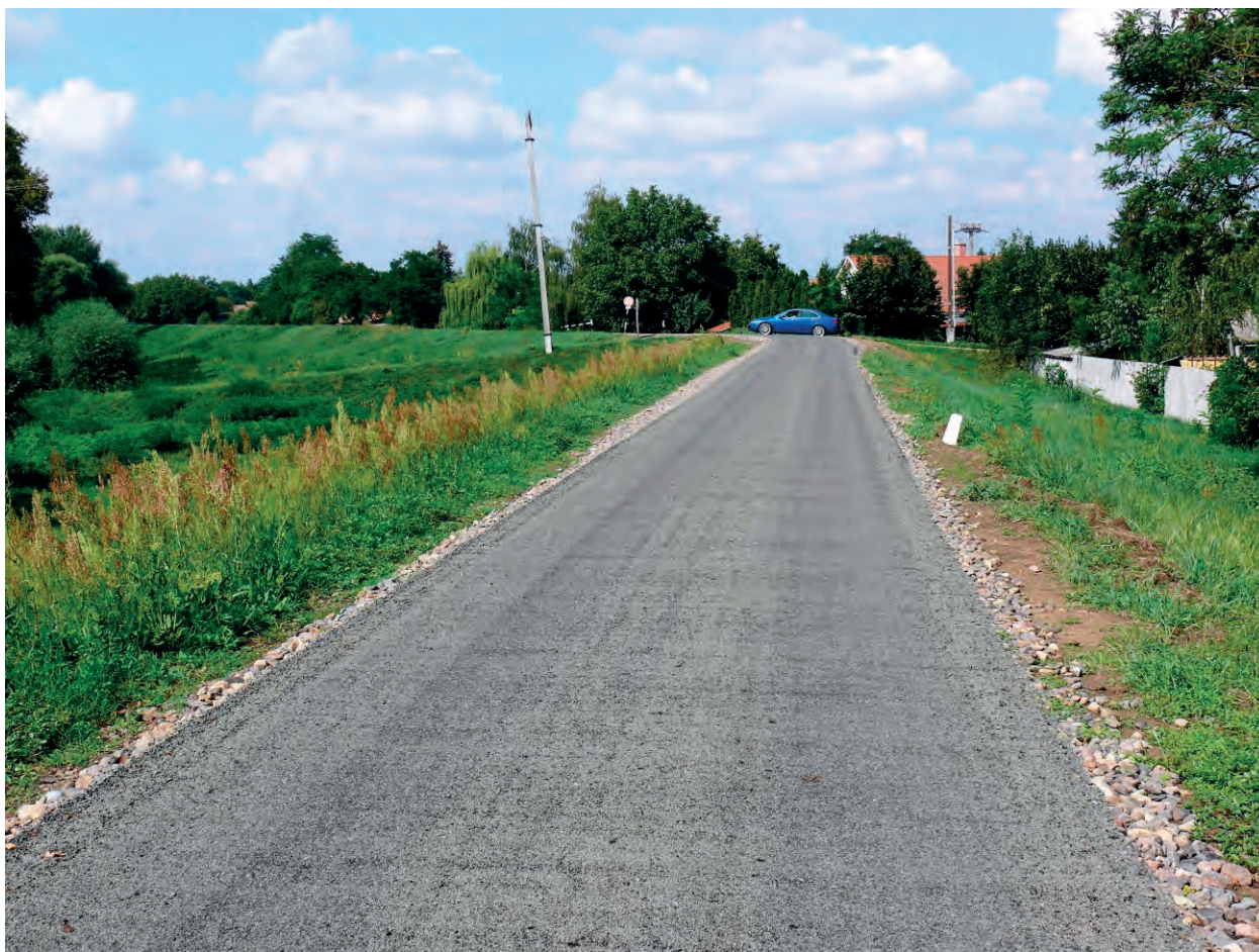
62. kép A projekt keretében megerősített és burkolt töltésszakasz Nagykörűnél
