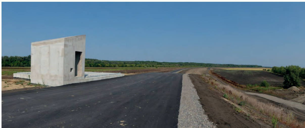
63. kép Az óballai töltésáthelyezés az épülő új műtárggyal
