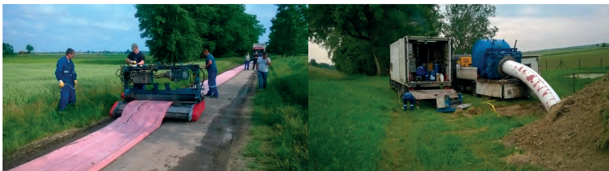
60. kép I/3 Foktorok szivattyútelep DN 800 acél nyomócső bélelése
