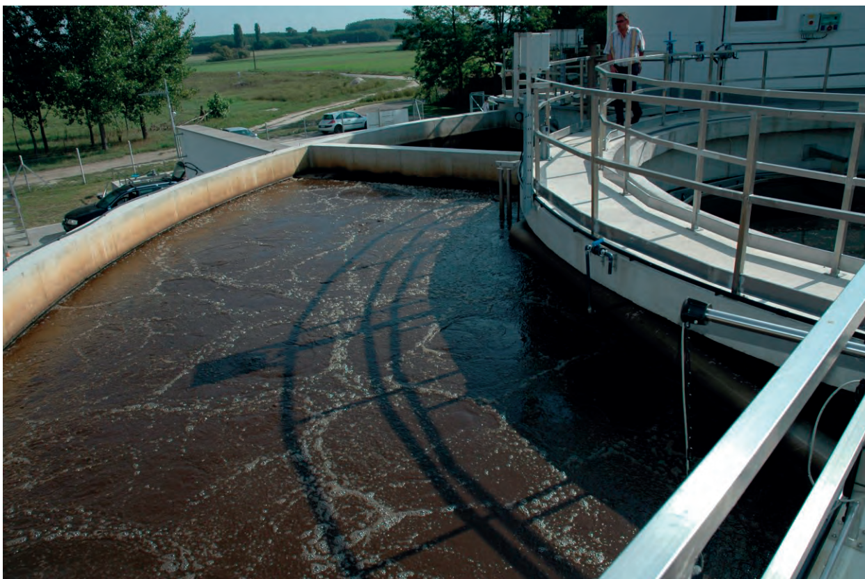
15. kép Eleveniszapos rendszer levegőztetett medencéje
