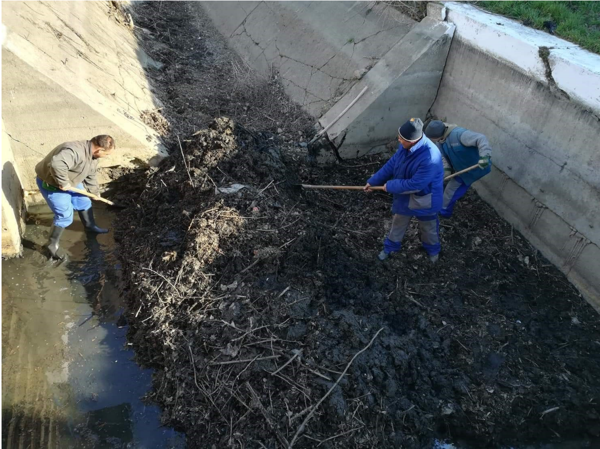
51. kép Tiszafüredi öntöző főcsatorna karbantartása
