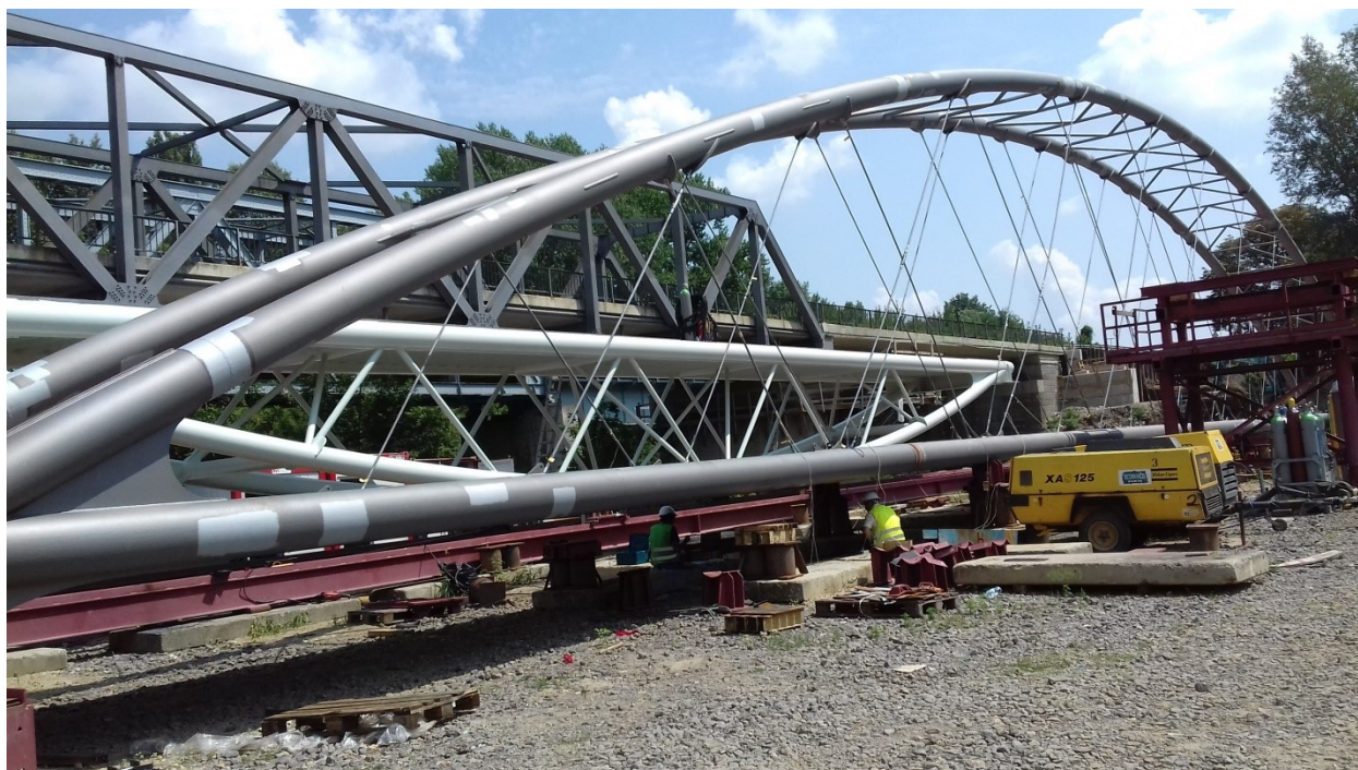
26. kép kerékpáros híd építése
