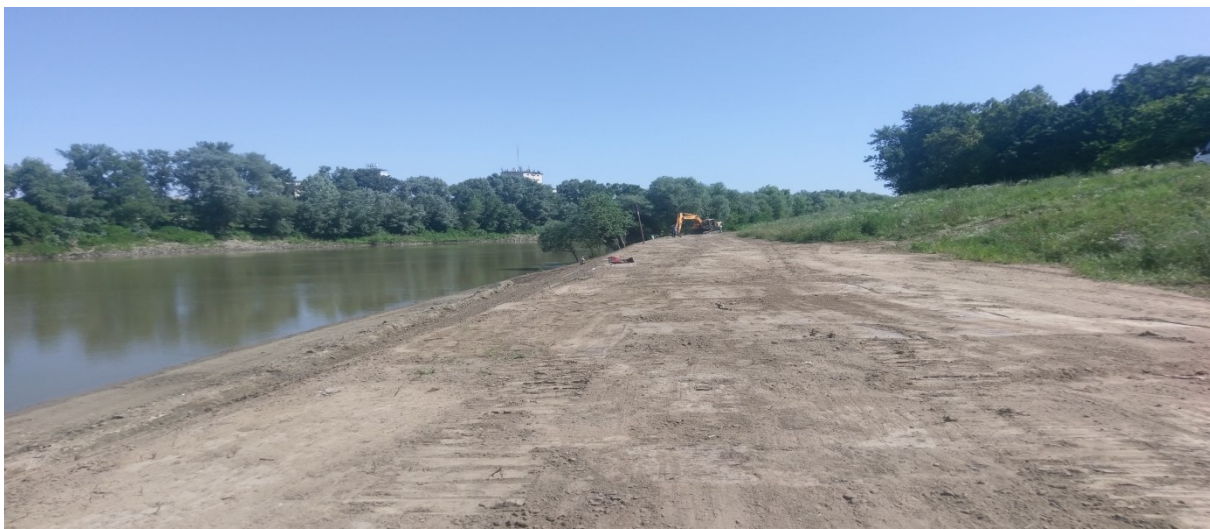
21. kép Mederrézsű rendezése
