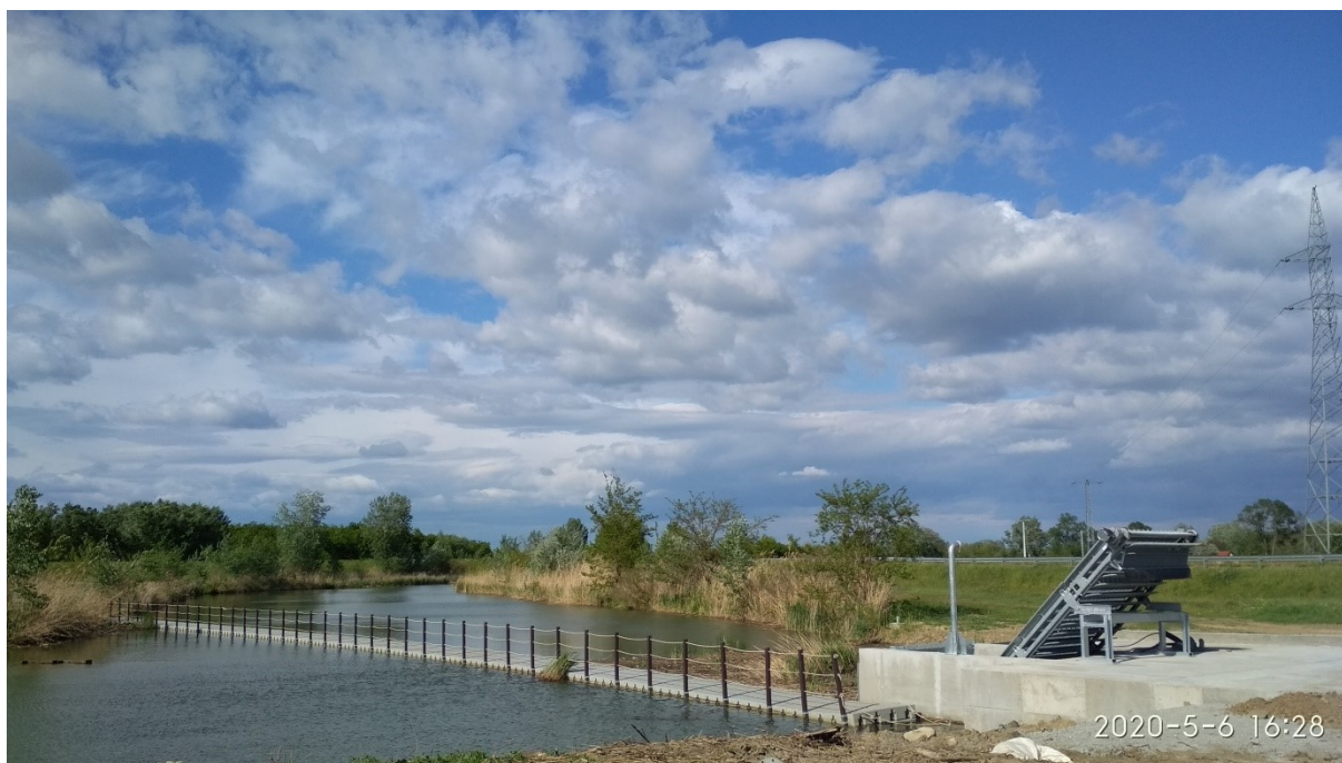
52. kép Gépi gereb és járható merülőfal
