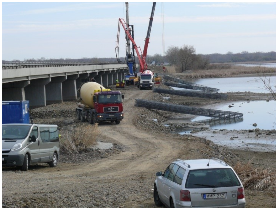
25. kép Az Eger-patakon áthaladó kerékpáros híd pilléreinek alapozási munkái
