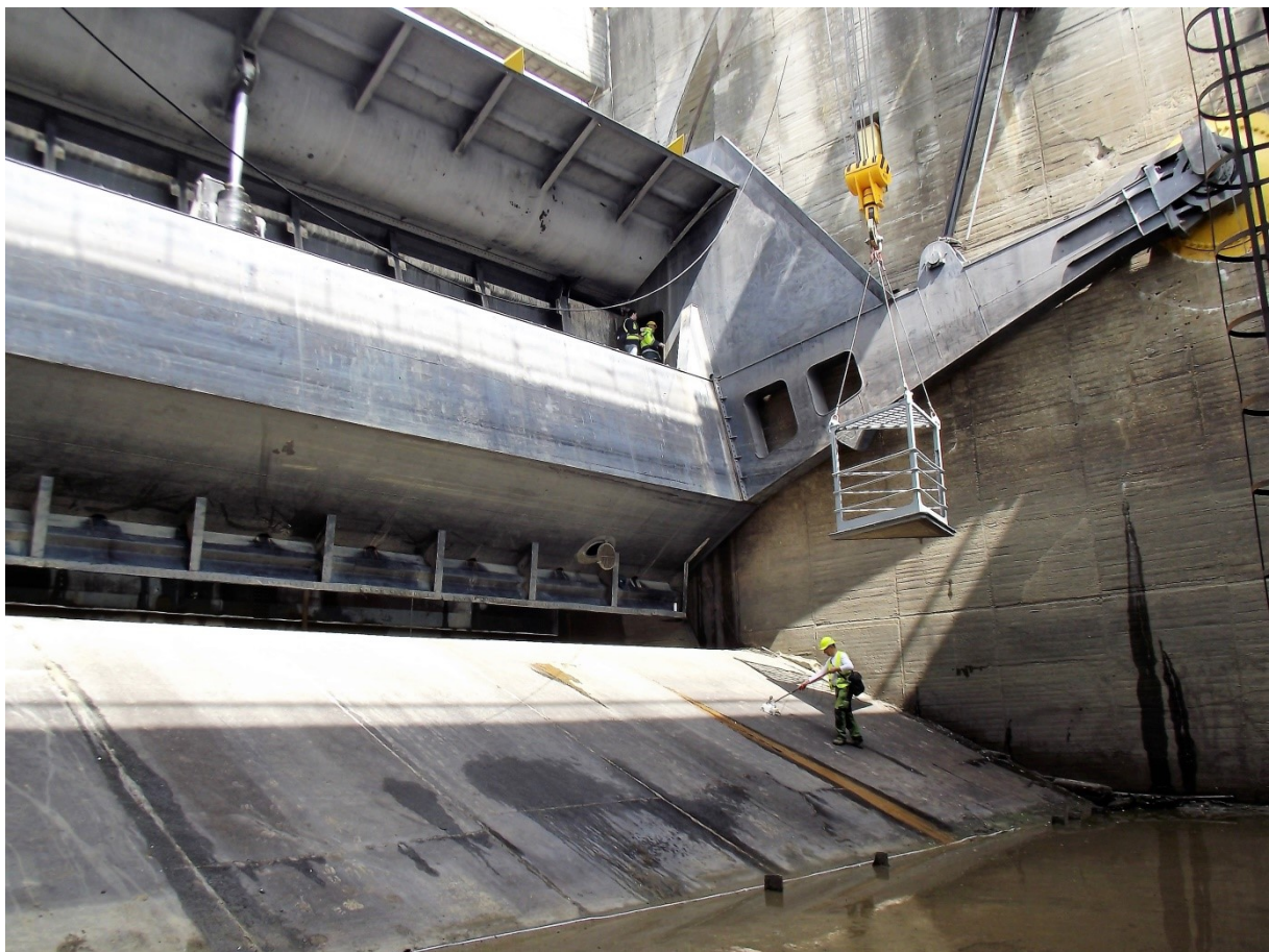
53. kép Munkálatok a kettes nyílásban
