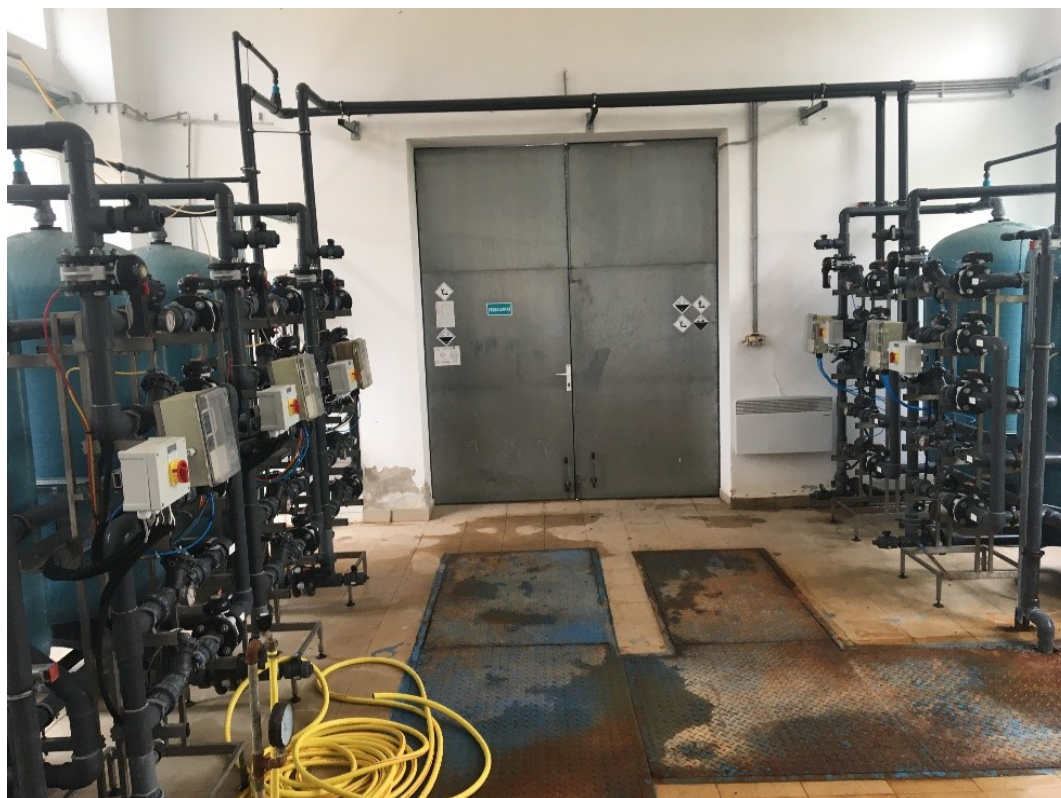
13. kép Örményes települési vízmű kezelőépület
