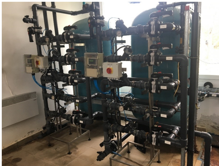
15. kép Örményes települési vízmű 2 db aktívszén adszorbens szűrő
