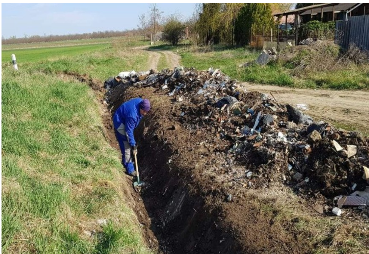
50. kép Hulladék kitermelése csatornából Szolnokon
