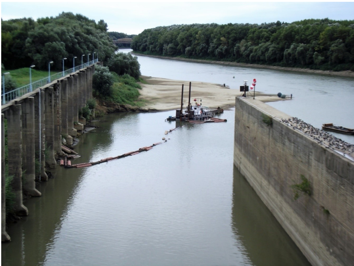
24. kép Kiskörei hajózsilip alvízi várakozó terének hidromechanizációs kotrása
