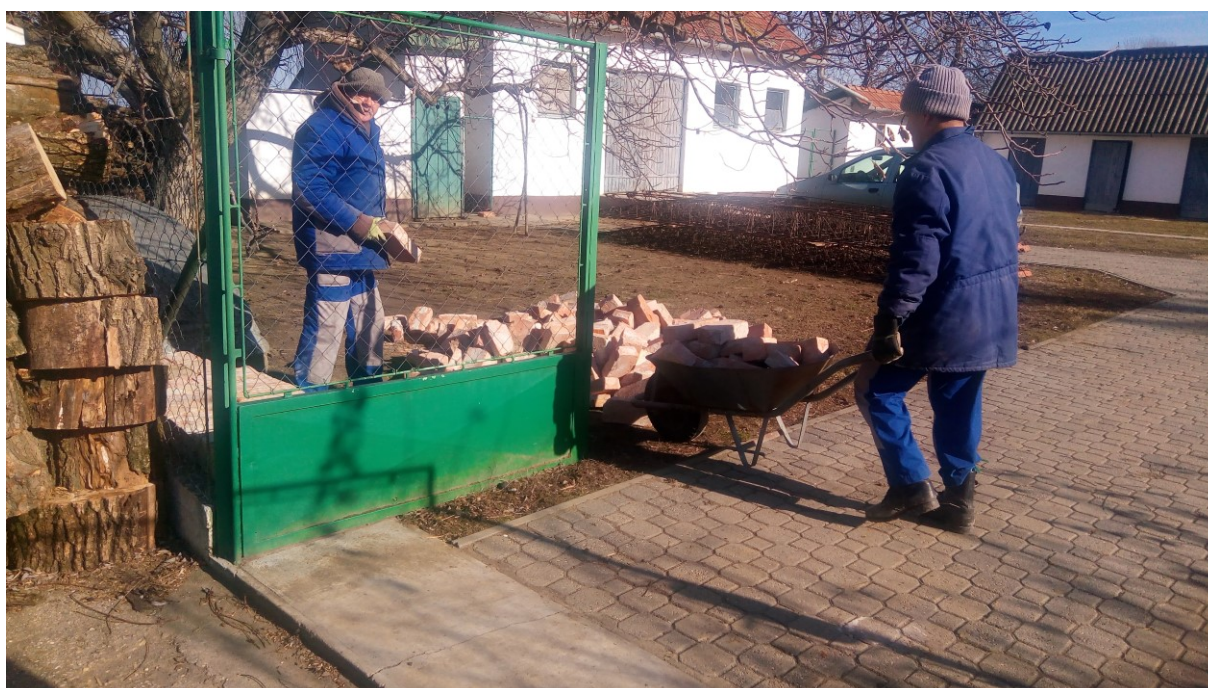
45. kép Tizsakécskei 10.01/2 örtelep karbantartása
