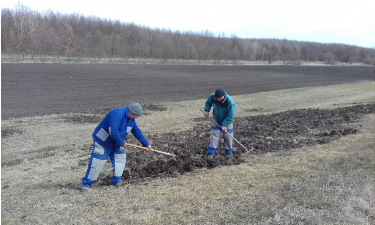
47. kép HTS tározó töltésén vaddisznókár helyreállítása
