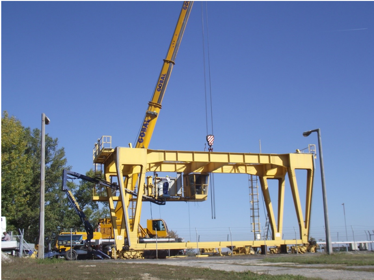
27. kép Hullámtéri daru felújítás közben
