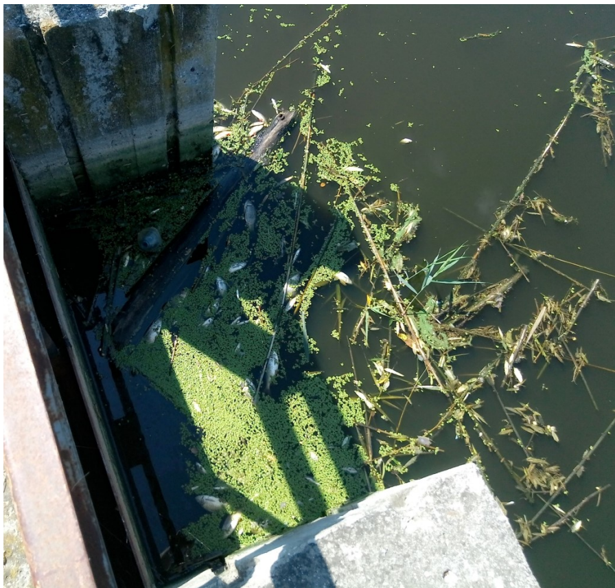
33. kép Halpusztulás a Csátés-csatorna 4+950 szelvényében 2019. szeptember 5.
