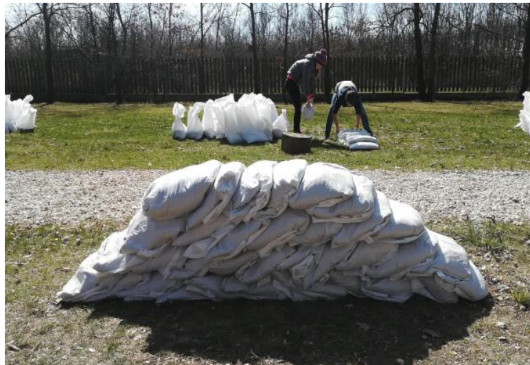
60. kép Védvonal építés homokzsákból
