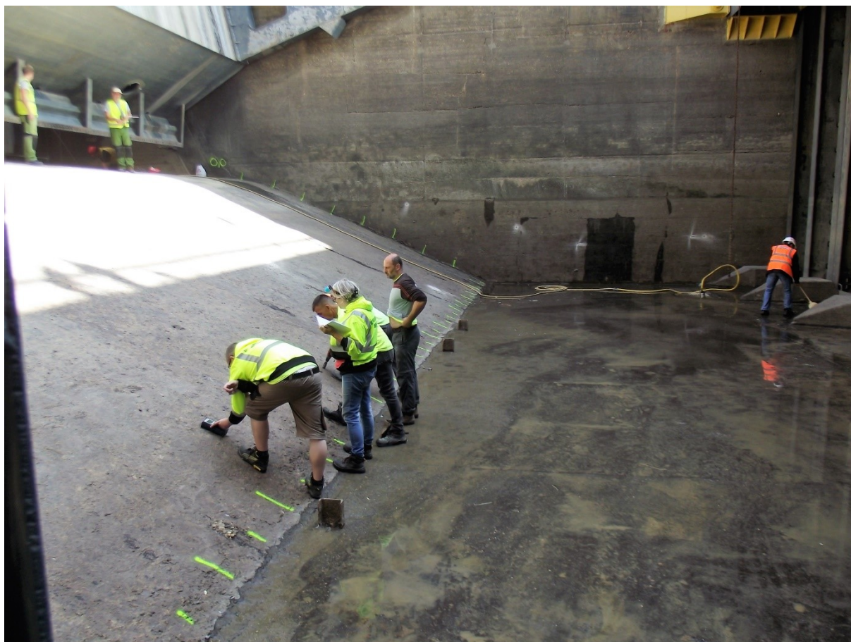
28. kép Kopóbeton vizsgálat a kettes számú duzzasztónylásban
