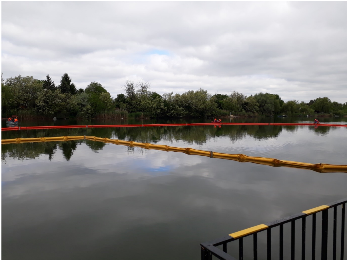
34. kép Alcsi-Holt-Tiszán feltételezett szénhidrogén szennyezés lehatárolása merülőfal használatával 2019. május 16.
