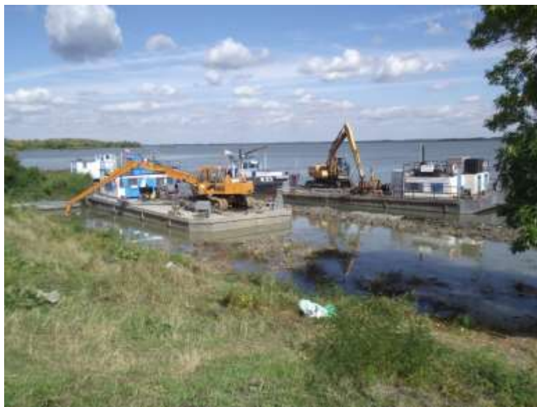
Partvédő mű építése Sarud térségében
